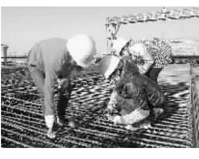
为确保2月26日完成局投产鉴定,3月5日通过箱梁部级取证,中铁四局五公司昌赣客专2标丰城东制梁场春节期间组织施工,完成了取证前需试生产的16片箱梁预制任务,同时完善了机具设备、技术管理、质保体系等各类箱梁生产取证的基础准备工作。图为施工人员在绑扎钢筋。
