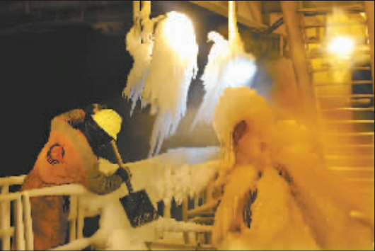
午夜时分,海冰随着水气堆积爬上平台底层甲板,冲冰的热水也冻在桩腿上,巡检至此的巡检工牛德成抡起铁锹除冰。
