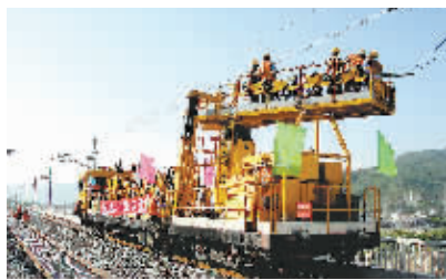
海南西环电气化接触网架梁架设线
