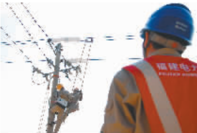
国网福州供电公司实施地电位带电作业为业扩工程接火
