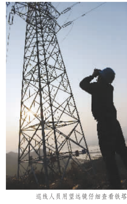
巡线人员用望远镜仔细查看铁塔
