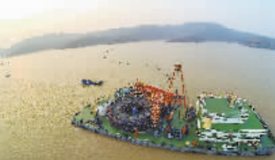
世界首个五端柔直示范工程海螺敷设施工
