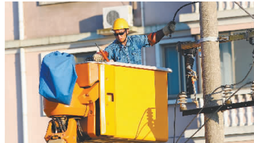
青浦公司带电作业人员正在高温下开展作业
