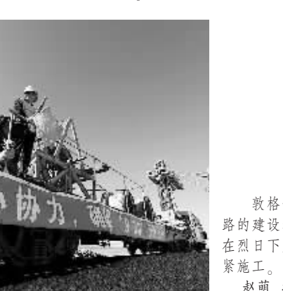
敦格铁路的建设者在烈日下加紧施工。 赵萌 摄
