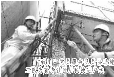
“致用”党员服务队队员协助施工队为新社区居民安装户线
