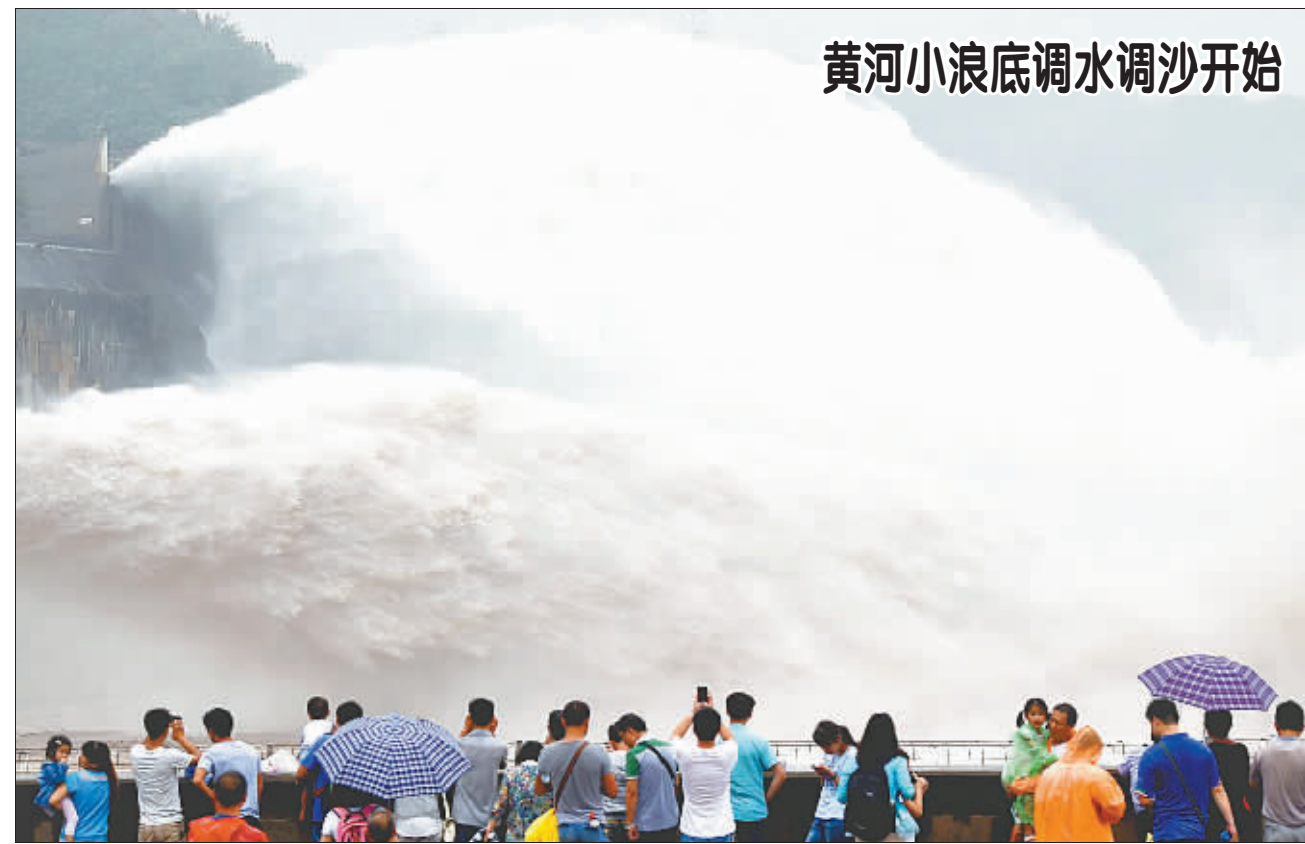
6月29日,游客在黄河小浪底水利枢纽工程出水口观看泄水的壮观景象。 当日,2015年黄河小浪底调水调沙正
