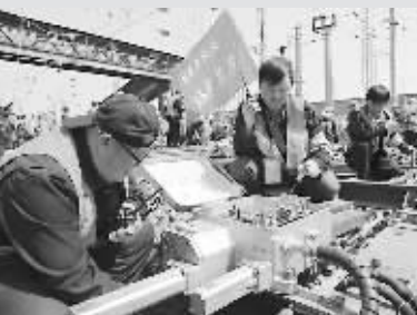
大同电务段党委在大同站改造施工期间,组织党员骨干成立党员突击队,通过集中开展“带头执行作业标准,带头落实安全措施,带头制止违章违纪”的“三带头”主题实践活动,全力卡控施工安全风险。 陈明磊 摄
