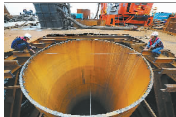
这两位青年工人正在熟练地用两根细线和一把尺子确定钢桩的圆心点,为对接下一节钢桩做准备。
