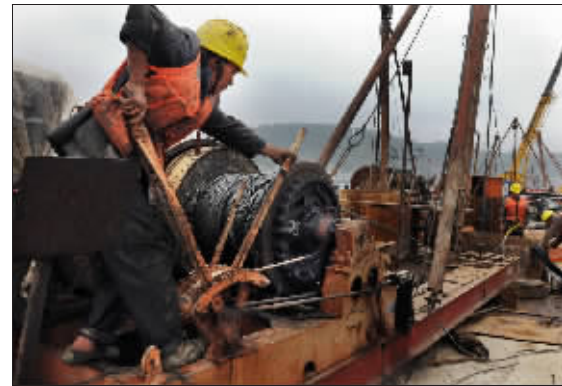
5月31日,一号找桥的施工人员正在用冲击钻为28号桥墩的海底桩基钻孔。
