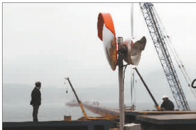
5月31日,图左这位家住平潭境内的老乡,绕着走了十几公里的路来到大桥工地看望。他说:“大桥建成后,我们到福州只有不足一刻钟的车程。”
