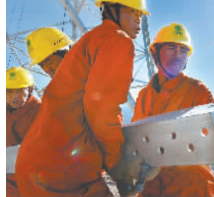
川藏联网工程施工人员正在进行塔材组装机位。王鑫摄
