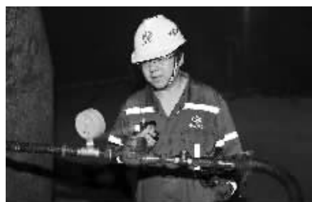
洪开荣在烟台LPG项目查看隧洞注浆效果。
