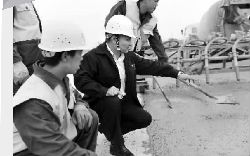
项目经理吕鹏涛现场指导施工
