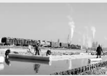
混凝土场坪养生
