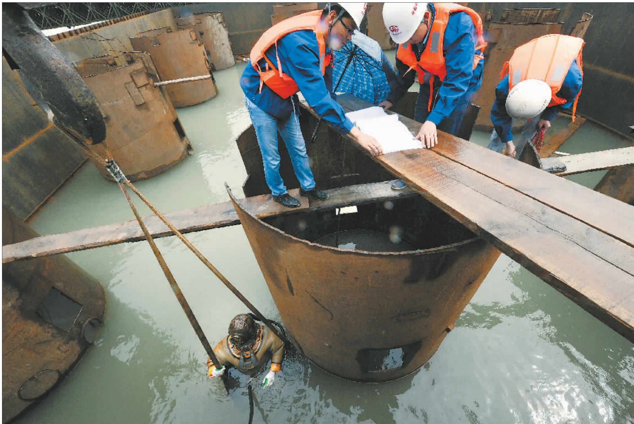
5月2日,冒着蒙蒙细雨,郝晋新带领着创新工作室的成员们,对淮南孔李淮河大桥工程施工中关于采空区桥墩固定的攻关课题进行最后一次现场数据核查。
