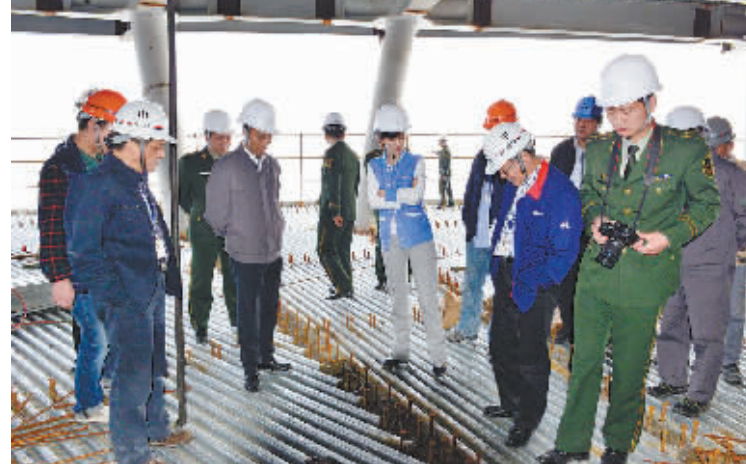
定期对现场进行安全生产检查
