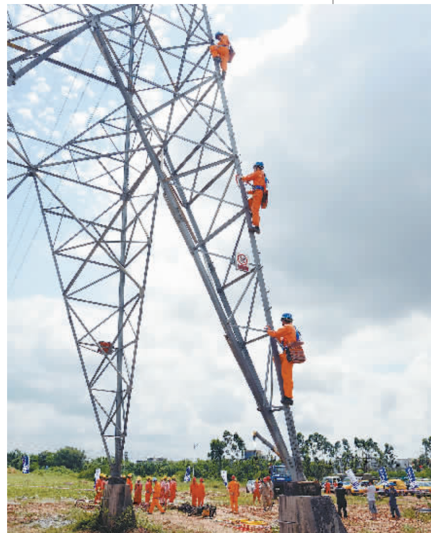
举行综合演练现场,工作人员在爬塔修复电线(谭文强 摄)
