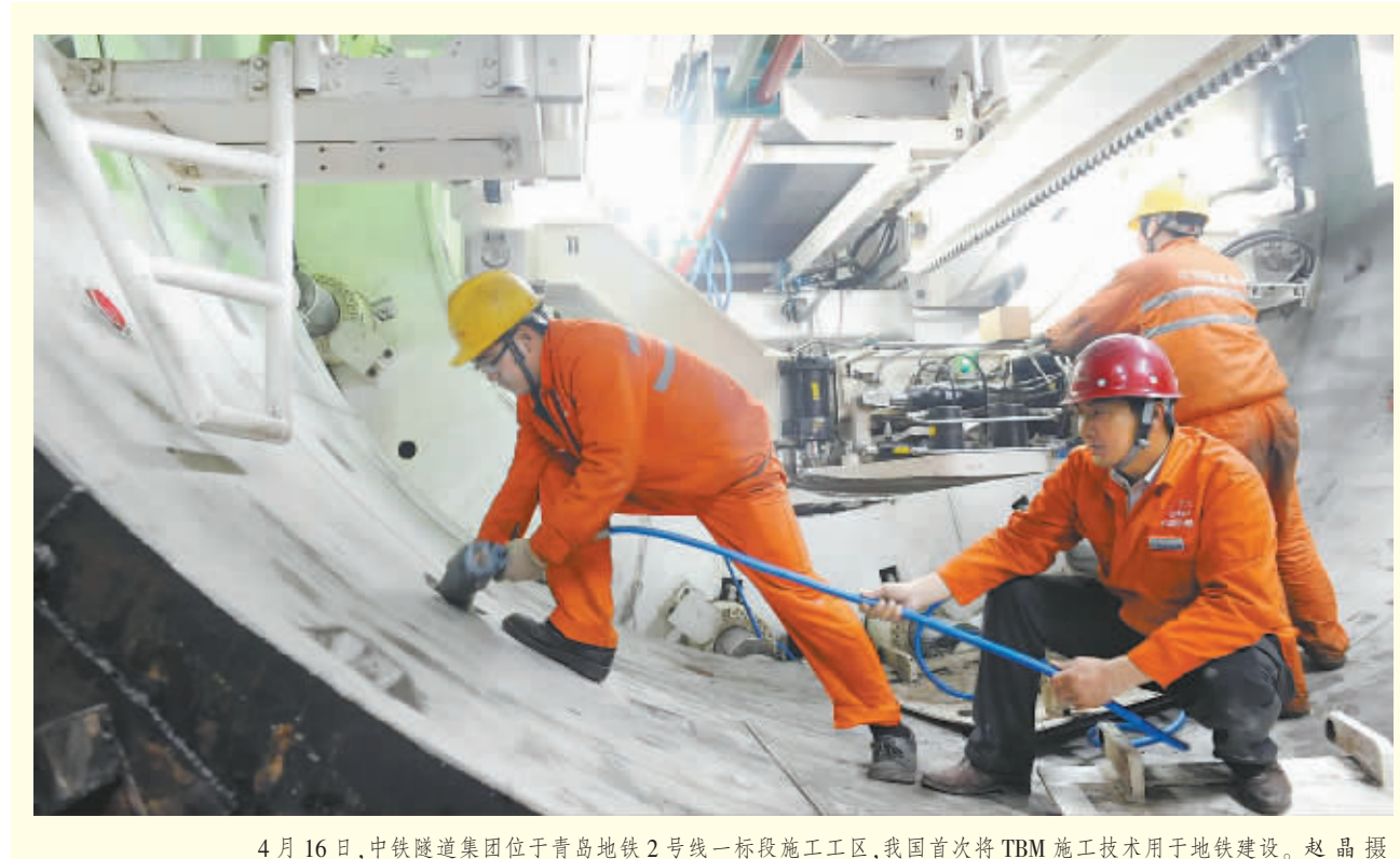
4月16日,中铁隧道集团位于青岛地铁2号线一标段施工区,我国首次将TBM施工技术用于地铁建设。赵晶摄
