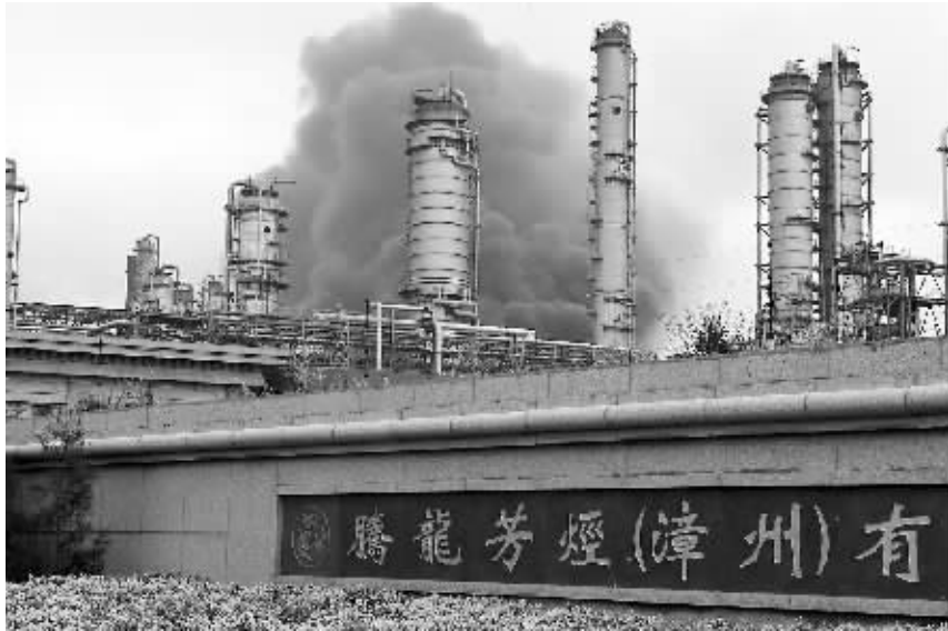
2015年4月7日下午,福建漳州,腾龙芳烃(漳州)有限公司着火罐体已基本被扑灭,火势已得到有效控制,现场依旧浓烟滚滚。 东方IC
