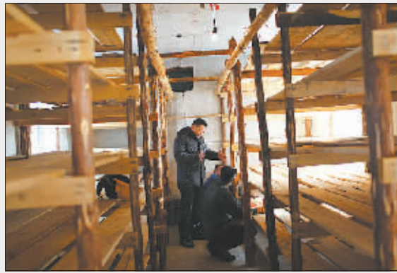
工人们正在新建的苗房里搭建木架准备种植木耳。
