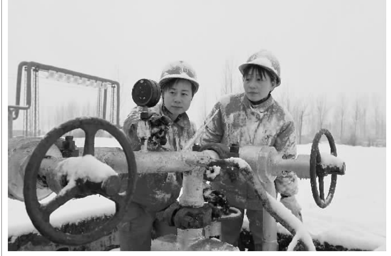
“风雪丽人”战寒冬 1月27日,2015年第一场大雪降临,河南油田采油二厂百里油区一片银装素裹,可也给我一线稠油生产带来诸多麻烦。井楼油矿采油四队32号计量站的姐妹们不惧风雪严寒,努力完成各项工作任务。 图为1月28日,32号计量站站长王学梅(左)与职工郭秀霞(右)顶风冒雪在楼2312井认真录取资料。 崔洪武 摄影报道
