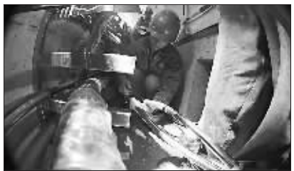
金山供电加紧制作电缆阻水接头
