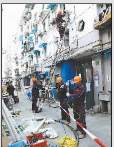
市区供电公司“光明工程”施工人员在瞿四小区展开表计线路路换。
