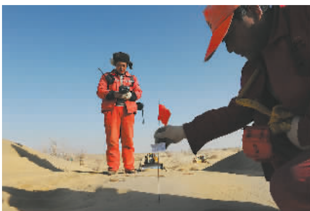
勘探队员克服施工环境艰苦、气候条件恶劣等困难。(摄于2014年12月27日)
