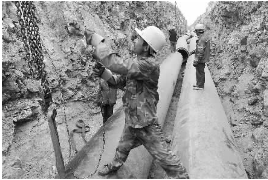
河南省一城市地下管线建设施工现场。 尧海摄/CFP
