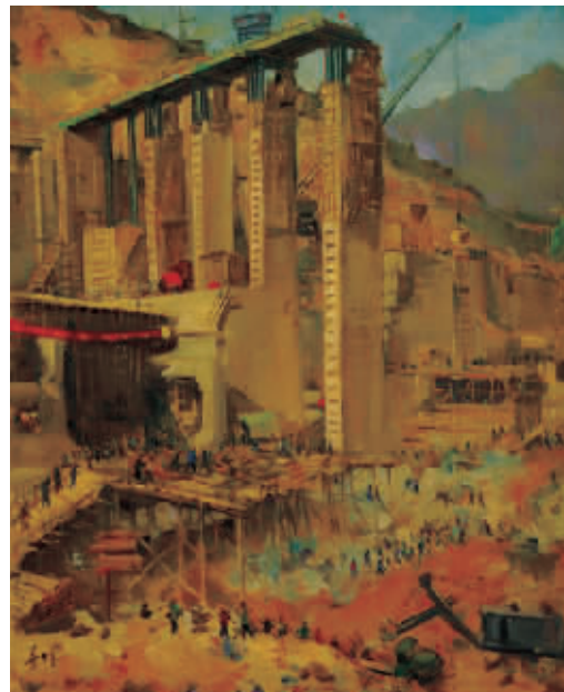
新安江大坝建设工地(油画) 胡善徐
