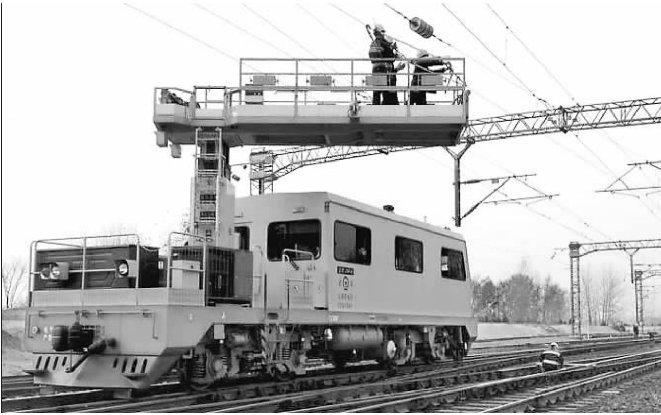
武汉铁路局冬季检修铁路运行质量
