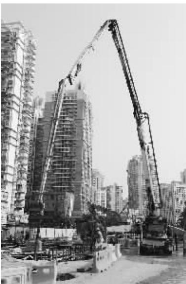
位于厦门市市中心闹市地段,采用明挖及部分盖挖施工的吕厝站,为厦门市轨道交通1号线与2号线的换乘站。高密集的商业区、居民住宅、人流、车流,构成了车站施工环境的复杂性。中铁十八局集团公司为了打好这一闹市地下攻坚战,通过精密测算,将结构复杂的车站总体分割成9期组织突破。图为混凝土输送泵车作业现场。
