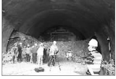
沪昆客专贵州段背阴坡隧道是全线重难点工程，近日，中铁二十二局五公司沪昆项目部顺利完成这一“穿越”。据介绍，这项工程从规模、技术、沉降位移变形控制，以及浅埋偏压、高速公路路面动载的复杂应力、软弱地质条件下的隧道防坍塌施工技术等在国内均属首例。项目部攻克洞内可能发生坍塌或沉降引发的地表沉降、裂缝等所有技术难关，确保了公路的安全运营。
