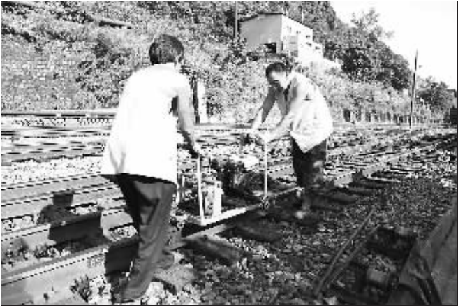
沈康和张发海对铁轨表面、侧面擦痕进行检测、打磨。
