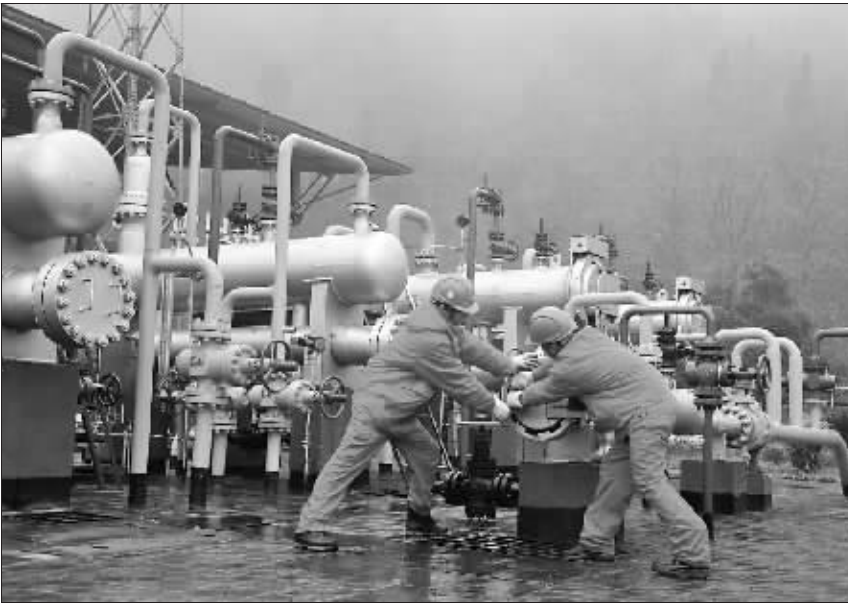
忠县作业区龙头增压站员工打开池34井至池11井的收球筒快开盲板进行收球操作,清除管线污物,提高管输效率,降低管线运行压差,保证管线清洁、高效运行。丁会 摄
