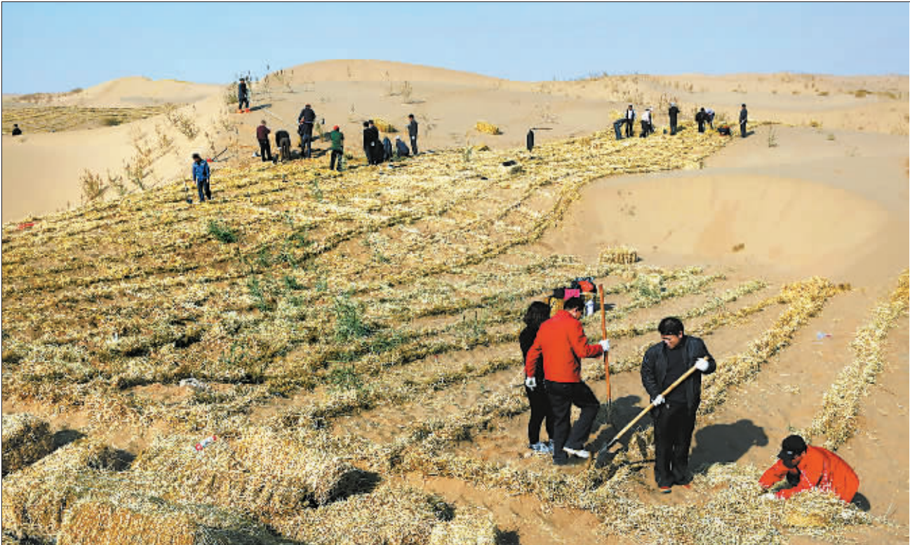
10月29日,甘肃省武威市干部职工在凉州区洪水河东岸荣华探矿路沿线用麦草网罩沙障。 近日,在武威市凉州区洪水河沿岸,古浪县民调渠沿线,民勤县青土湖等沙漠区域,每天有数千名机关干部及当地群众奋战在防沙压沙第一线,构筑防风固沙生态屏障。 姜爱平 摄
