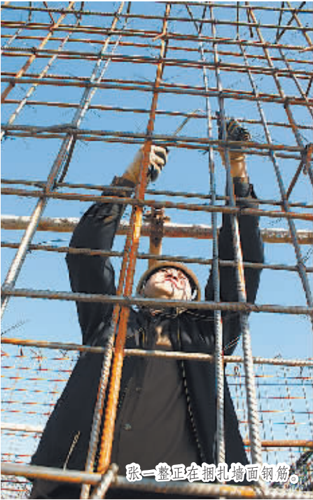
钢筋的布置需要工人弓着腰一根一根地摆放,钢筋的固定需要工人蹲着一个结一个结地捆扎。“一天下来,腿脚和腰跟石头一样,硬得动弹不了。”
