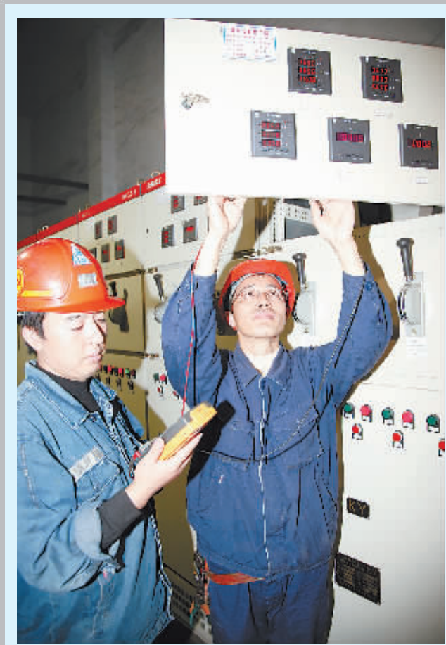
2011年10月1日,游弋与同事在车集煤矿副井口变电所调试低压开关柜。
