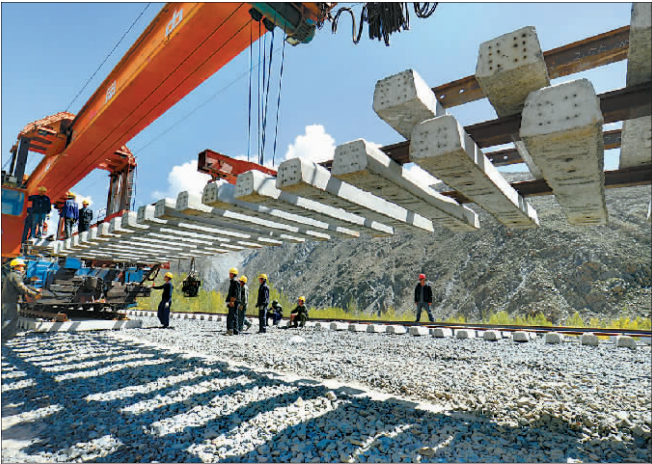
铁路首次飞跨雅鲁藏布江 9月24日,工人正在进行拉日铁路雅鲁藏布江一号特大桥铺轨作业。当日,拉日铁路雅鲁藏布江一号特大桥铺轨,首次实现铁路横跨雅鲁藏布江。拉日铁路为国家I级铁路,全长253公里,列车运行时速将不低于120公里,全线设拉萨南、曲水、尼木等13个车站,年货运量可达830万吨以上,预计2014年投入运营。拉日铁路建成后将进一步扩大青藏铁路影响范围,改变西藏西南部地区依靠公路运输的单一局面。 新华社记者 觉果 摄
