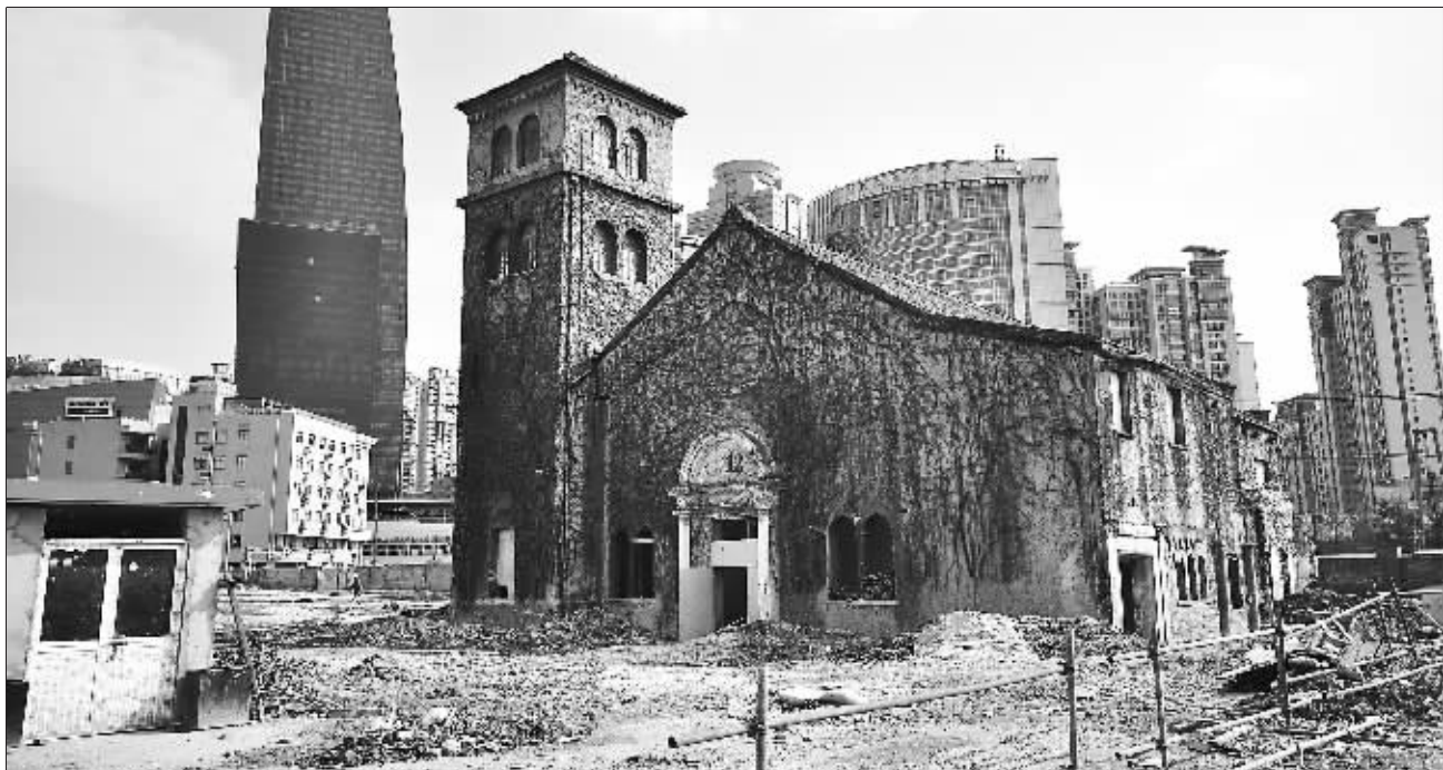
上海,荒废了近8年之久的张爱玲母校——百年名校圣玛利亚女校旧址施工队伍,原址将建三栋摩天大楼。学校7幢历史建筑沈春环/CFP
