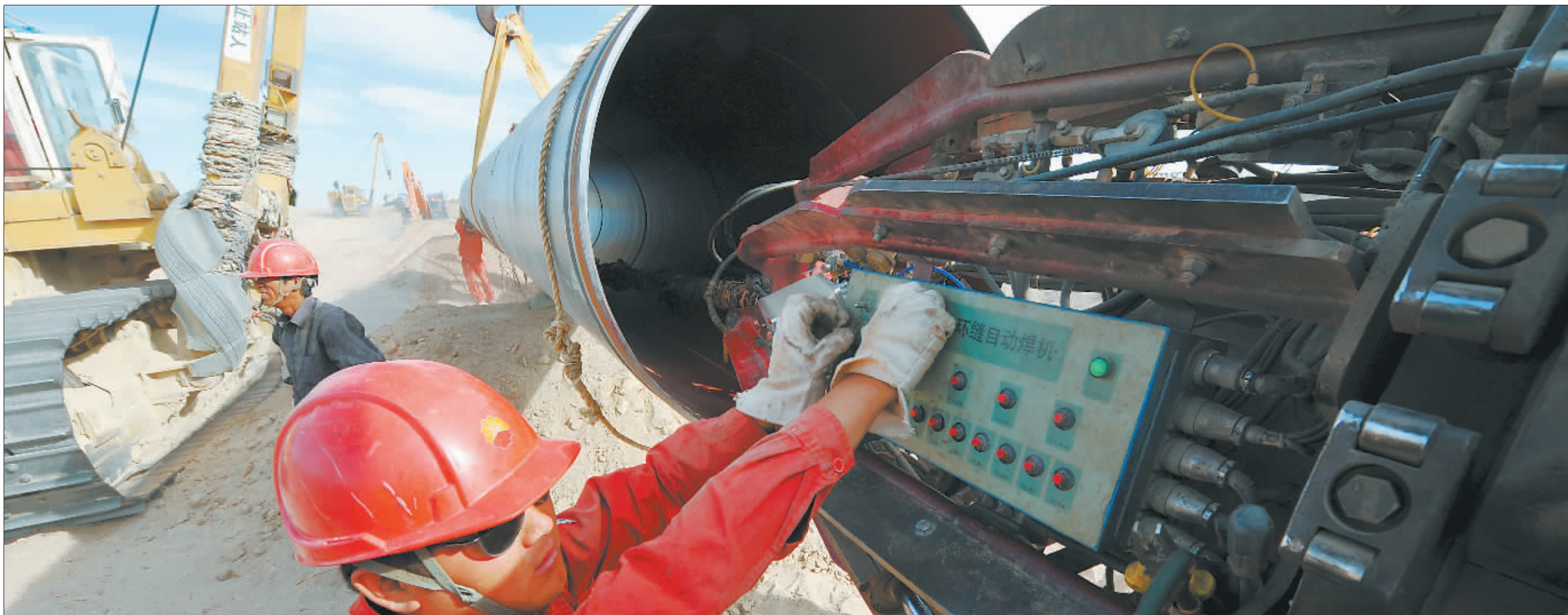
8月8日,工人们正安装全自动焊机。过去的手工焊,两个工人一天只能焊接两道管口,采用全自动焊机仅半小时就能焊接一道管口,不仅使焊接质量大大提高,而且降低了工人的劳动强度。
