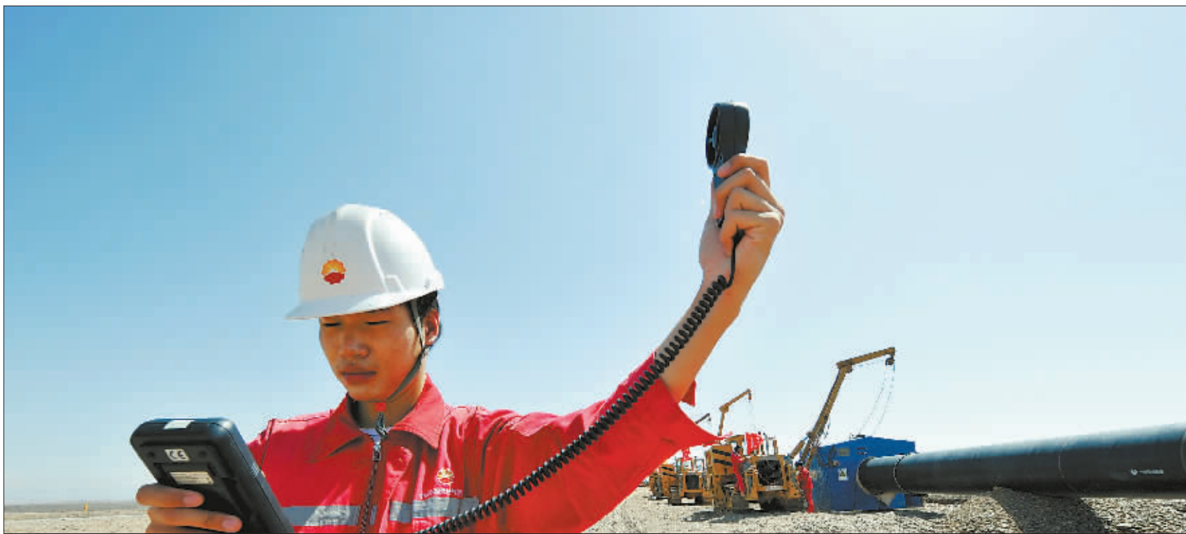
十三间房是“百里风区”的最大风口。8月8日,pp125机组质量员李杨用测风仪测得阵风10级,他告诉机组长,风力已超过施工要求标准。
