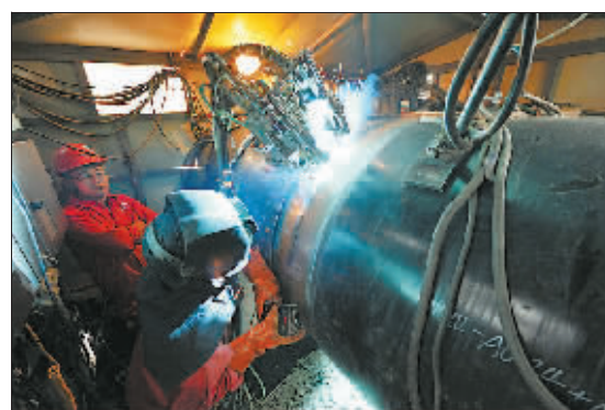
除特殊地段外,电焊工已丢掉了传统焊枪,全自动焊机的快速、高品质使管道焊接进入了一个全新时代。
