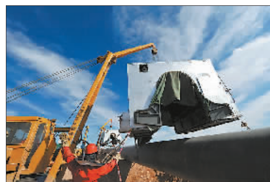
8月7日,几台吊车同时在吊装全自动焊接棚,机械化施工使工程进度得到保障。
