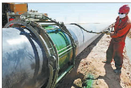
8月7日,喷涂控制工尚进卫用手中的控制器操纵着自动化液态聚氨酯防腐补口设备,新设备的应用使管口防腐更快捷,质量更高。
