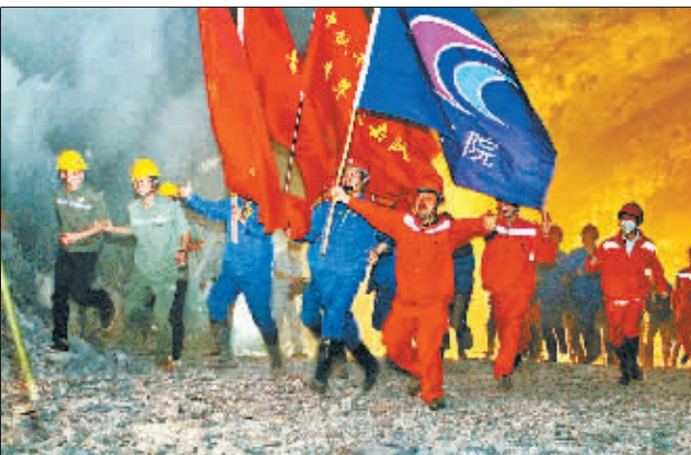
锦屏二级水电站引水洞贯通
