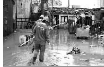
今年第12号“潭美”台风对浙江省瑞安市西部山区及近滨海地带6590余用户用电造成影响。暴风骤雨过后,瑞安市供电公司全体抢修人员带上装备及材料,迅速冲进风雨中。目前大部分受灾地区已恢复供电。(陈海卿摄)
