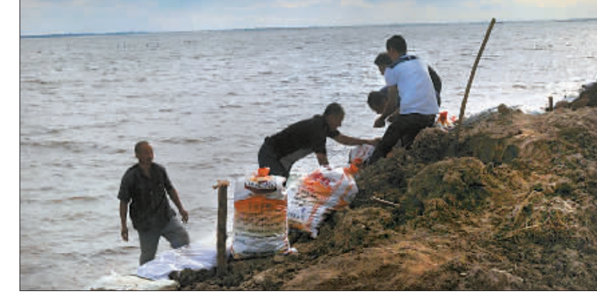
8月22日,抢险人员在吉林省前郭县库内泡水库修护大坝。 新华社记者 齐海山 摄
