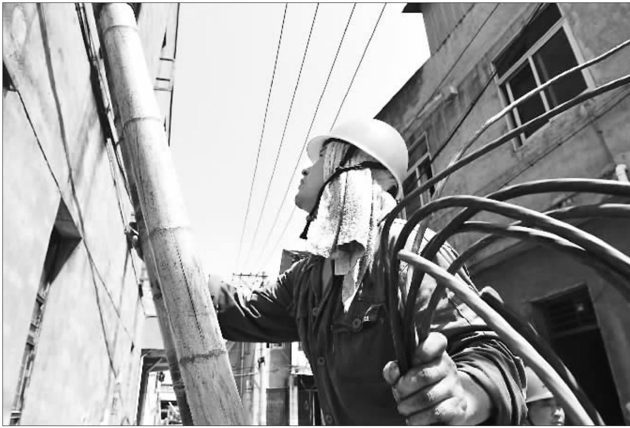
浙江省高温持续,国网瑞安市供电公司职工头顶40℃以上高温检修设备,确保用电安全。 薛若丹摄
