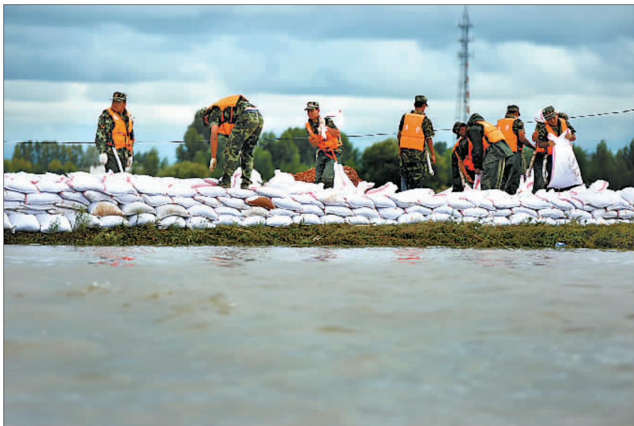
坚守“最险”堤坝
