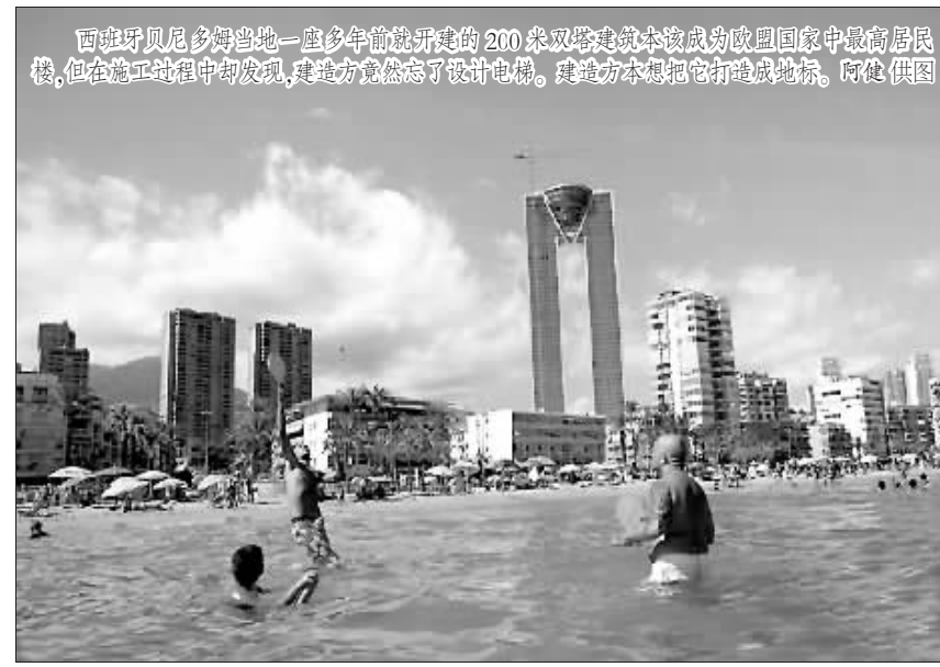
西班牙贝尼多姆当地一座多年前就开建的200米双塔楼被中途改造成欧盟国家中最高居民楼,但在施工过程中却发现,建造方竟偷改了设计电梯,建造方本想把它打造成地标。(何德供图)
