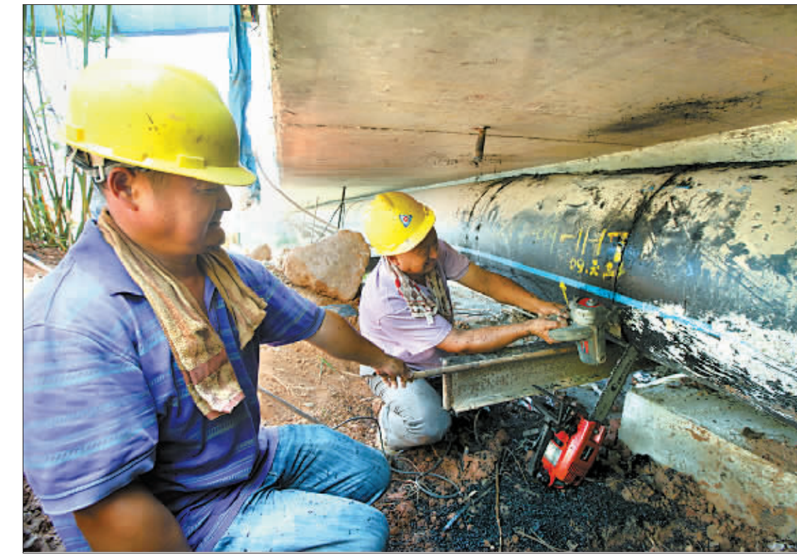
8月5日中午,安徽省黄山市自来水公司安装施工人员在黄山风景区进行管道维修。持续的高温天气使得城市供水管网负荷过大。为加强安全生产管理,保障城市供水安全运行,当地供水部门采取有效措施,通过安排专人和专用车辆实行全天候值守和巡护,及时消除供水故障,满足有关单位和居民的生产生活用水。 余勇 摄
