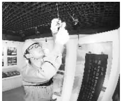
7月24日下午,温度高达41度,镇海供电公司工作人员为包玉刚故居、庄市老街等商帮文化遗址进行线路维护和更换工作,确保供电稳定安全。(金光杰)
