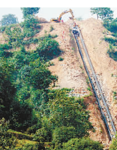
兰成中贵管道康县槽管台，全线最陡的斜坡35度角
