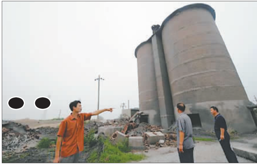
福益熟料厂近40米高的机立窑已被拆除,原料仓(图右侧)近日也要拆除,落后的机立窑时代将过去。 郑荣奎摄
