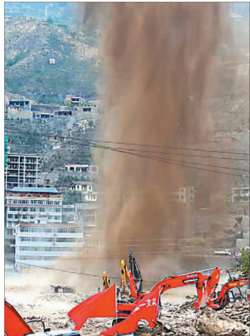
舟曲堰塞湖堰塞体实施第十次爆破。
