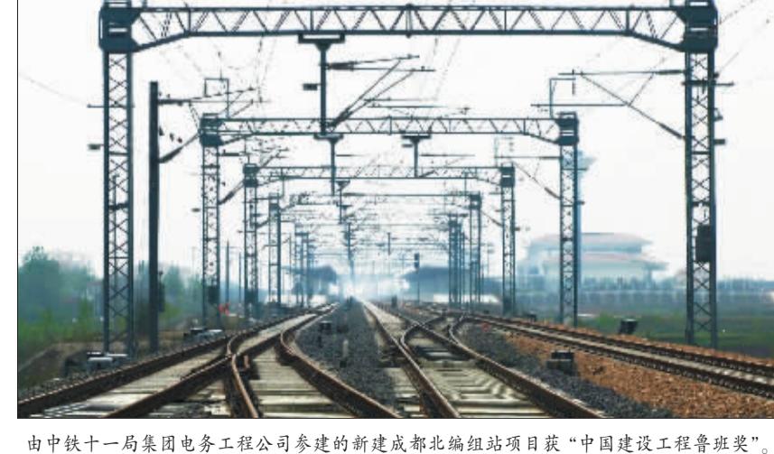
由中铁十一局集团电务工程公司承建的新建成都北编组站项目获“中国建设工程鲁班奖”。
