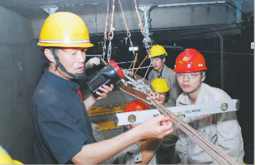
中铁十一局集团电务工程公司上海地铁项目部工地学校成为培养人才的摇篮。图为接触网专家(左一)在为职工讲授分段绝缘器安装调试工艺。
